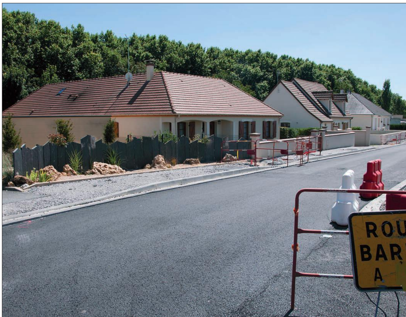
Un aménagement est cours d'achèvement
